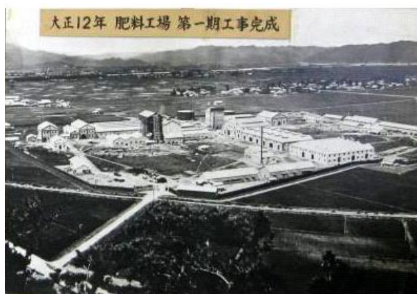
图 3. 延冈工厂全景(摄于 1923 年)
