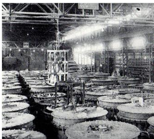
图 1. 日本氮肥公司的石灰氮炉
