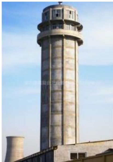
图 6. 高塔熔融造粒的造粒塔
