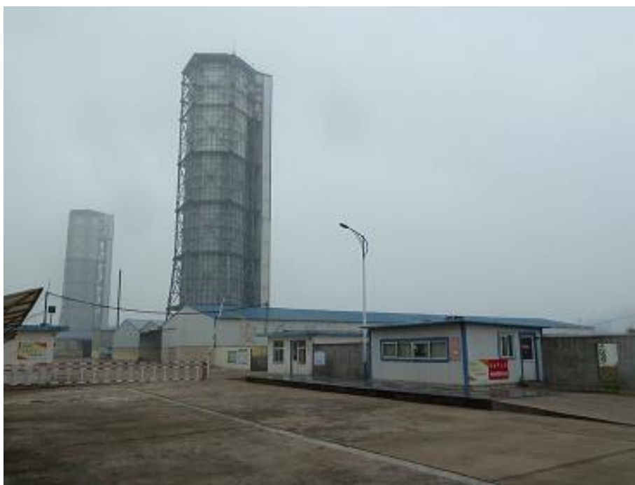
图 7. 中国山东省某高氮复合肥工厂厂区
