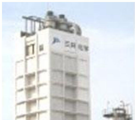
図 3. 三井化学大阪工場の尿素造粒塔 （高さ 40m）
