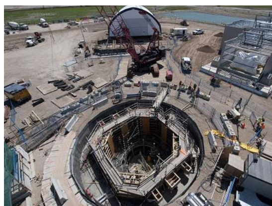
写真 2. Jansen 加里鉱山の縦坑建設現場
