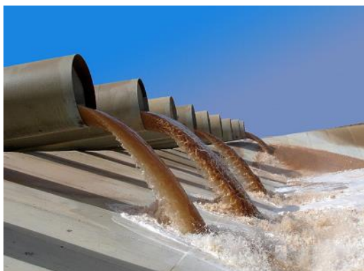
図 5. 塩湖鹹水を蒸発池に注入する
