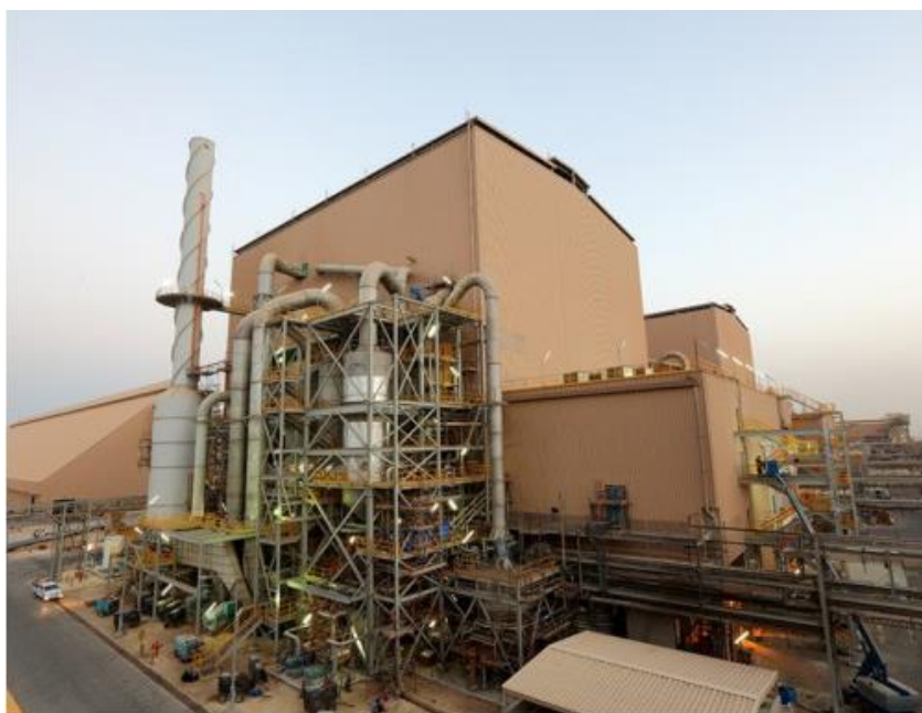
図 11. Ras Al Khair リン酸肥料工場の DAP プラント
