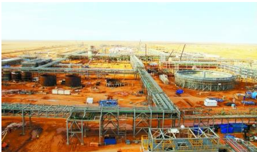
図 17. Umm Wu'al リン鉱山の選鉱プラント建設現場
