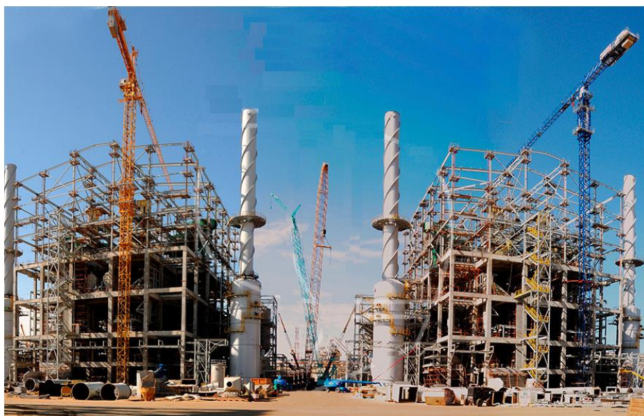
図 20. 建設中の DAP と NPK 化成肥料プラント
