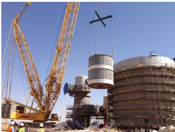
図 19. 建設中の硫酸プラント
