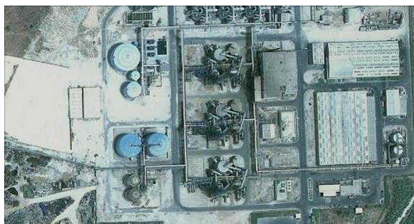
図19. Safi りんハブ工場第2ユニット
