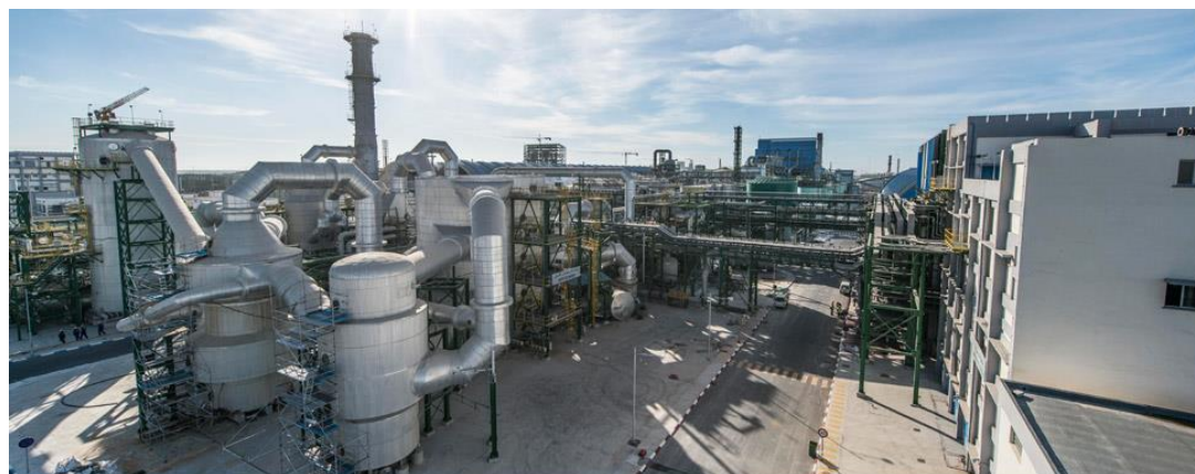
図 15. Jorf Lasfer りんハブ工場のりん安肥料プラント
