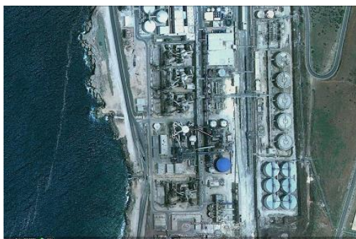
図18. Safi りんハブ工場第1ユニット
