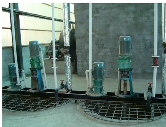
図 2. 原料スラリー混合槽の写真
