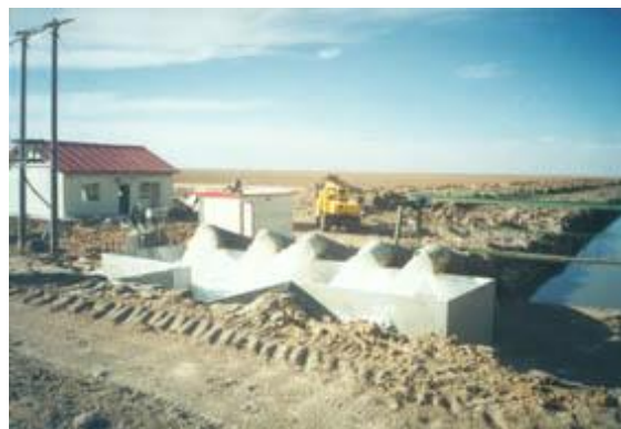
写真 15. チャルカン塩湖の鹹水採取溝とポンプ場
