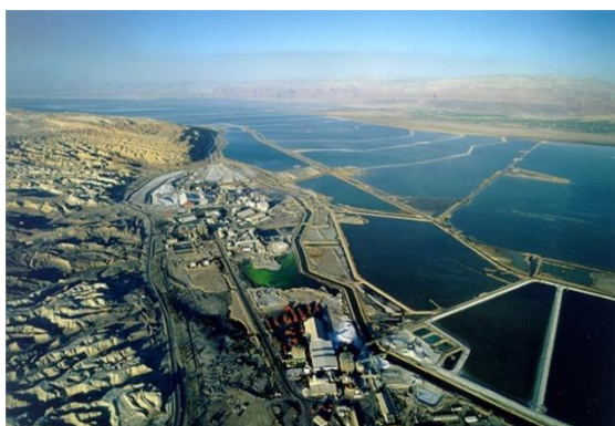
写真 12. 死海の南側にある濃縮池群、総面積は 200km 2 以上、死海表面積 1/6 を占める。
