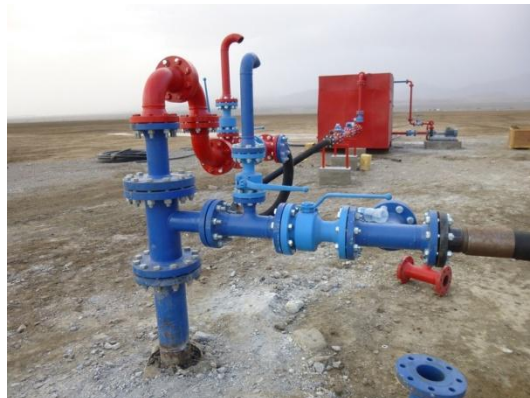
写真 17. 鹹水井戸。赤パイプは鹹水吸上げ用、青パイプは淡水用 (Danakhil)。
