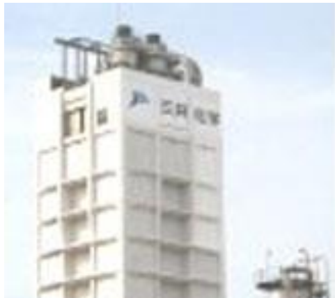
图 3. 日本三井化学大阪工厂的尿素造粒塔 (塔高 40m)
