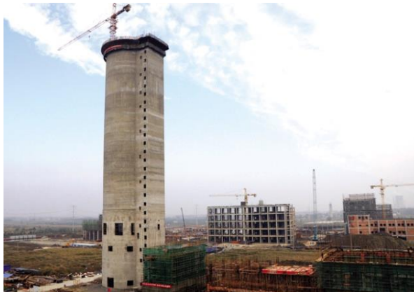
图 4. 中国锦邦化工公司的尿素造粒塔 (塔高 110m)
