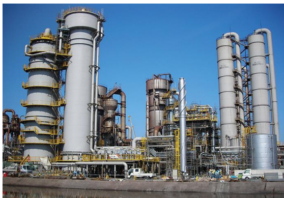
图 3. 日本制铁的炼焦气体的硫酸铵生成装置
