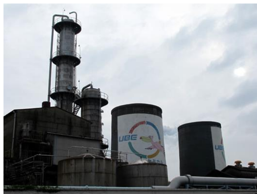
图 4. 宇部兴产的己内酰胺生产装置
